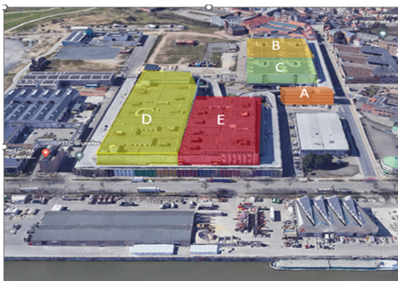
Site TIR avec les différents bâtiments (A, B, C, D et E)
