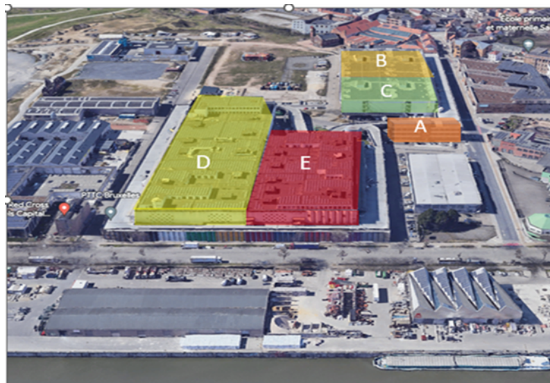
TIR-site met de verschillende gebouwen (A, B, C, D en E)
